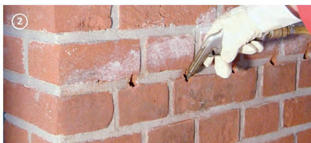
Ausblasen des Bohrstaubes
