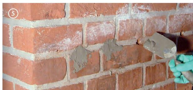
Verschließen der Bohrlöcher
