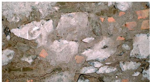
*Natursteinmauerwerk mit Lehmörtelfugen*
