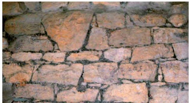
*Großformatiges Zyklopenmauerwerk mit grobporigen Fugen*
