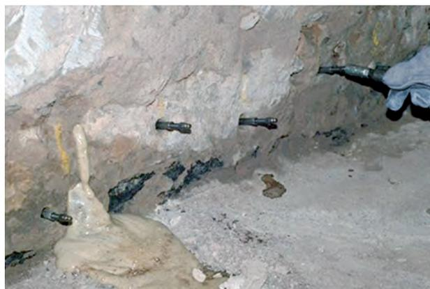
Vorinjektion eines PUR Injektionsschaumharzes in hohlraumhaltigem Mauerwerk
