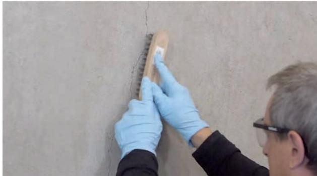
Abb. 1: Säubern der Bauteiloberfläche
