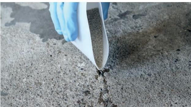
Abb. 5: Verfüllung des Risses nach dem Verguss mit Quarzsand
