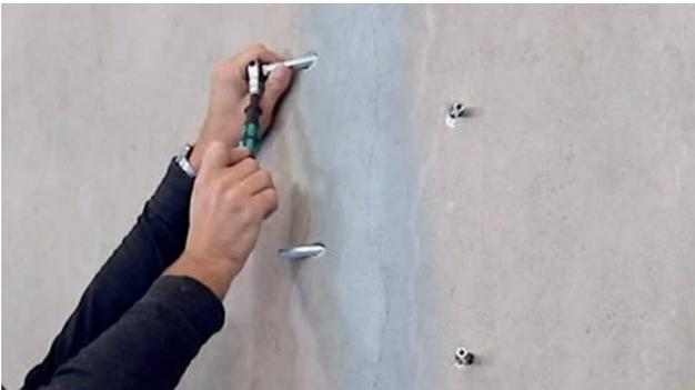
Abb. 3: Einbau der Packer
