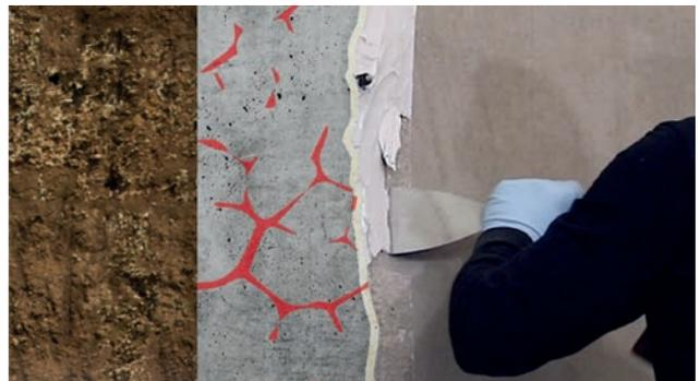
Abb. 6: Entfernen der Verdämmung und der Packer
