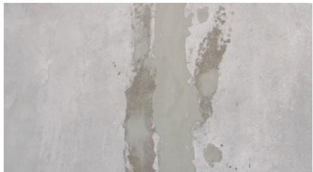
Abb. 6: Ausbau der Packer, Entfernen der Verdämmung und Nachbehandlung des Risses
