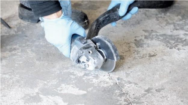
Abb. 1: Riss keilförmig öffnen
