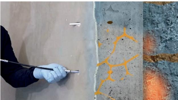
Abb. 5: Injektion von unten nach oben
