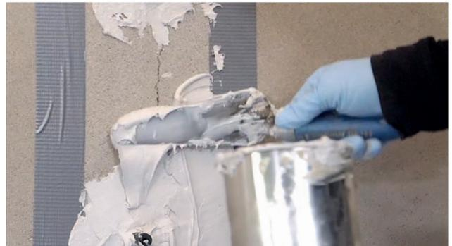
Abb. 4: Verdämmung und Einkleben der Klebepacker
