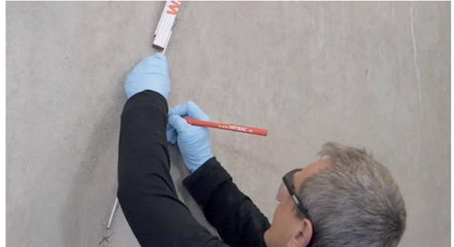
Abb. 2: Festlegen der Klebepackerabstände über dem Riss
