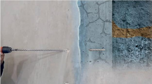
Abb. 1: Erstellen der Bohrlöcher
