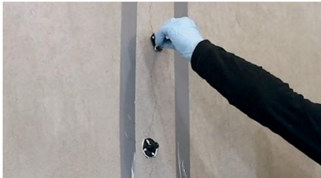
Abb. 3: Montage der Klebepacker über dem Riss
