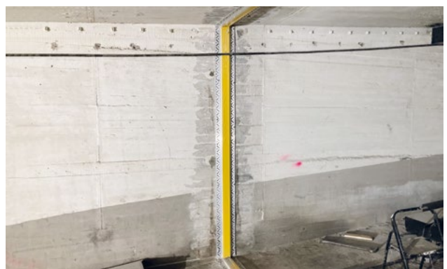
Abb. 6: Überarbeitung der Fuge
