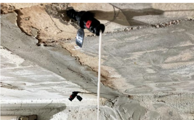
Abb. 5: Injektion des Materials
