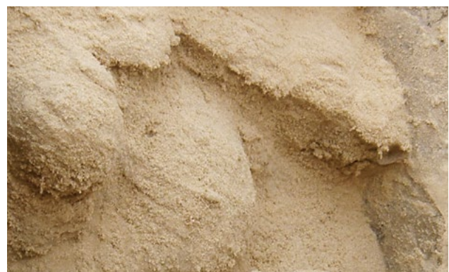
Abb. 6: Beispiel eines Gelschleiers nach der Injektion
