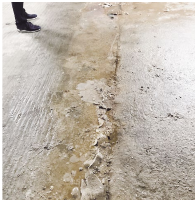
Aufnahme Bauzustand vor der Sanierung
