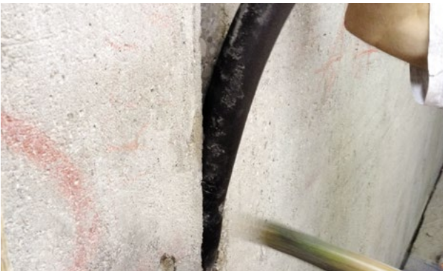
Abb. 3: Einbau des Einschlagprofils
