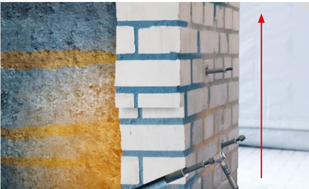
Abb. 3: Injektion von unten nach oben
