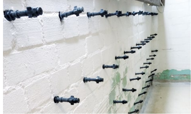
Abb. 2: Beispiel Packeranordnung
