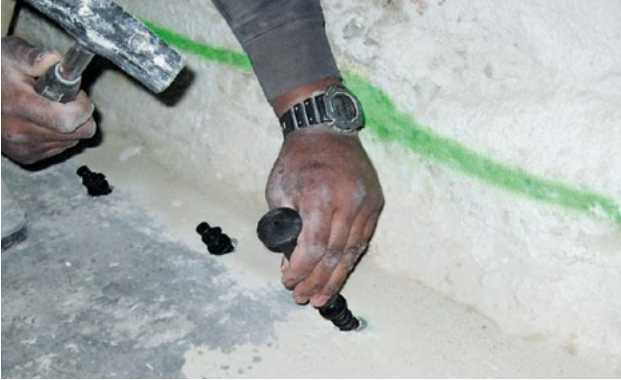
Abb. 1: Bohrlochraster anzeichnen, Bohrungen erstellen und Packer setzen
