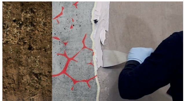
Abb. 6: Entfernen der Verdämmung und der Packer
