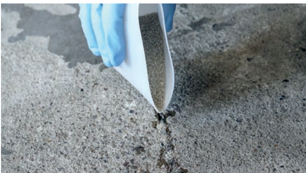
Abb. 5: Verfüllung des Risses nach dem Verguss mit Quarzsand
