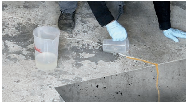
Abb. 4: Rissverguss mit EP Harz
