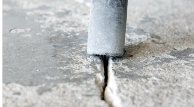
Abb. 2: Staub restlos entfernen
