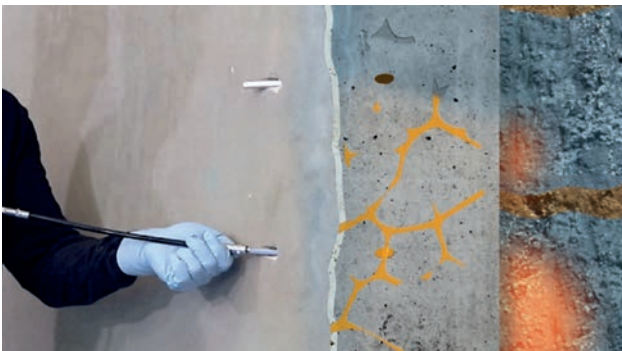
Abb. 5: Injektion von unten nach oben
