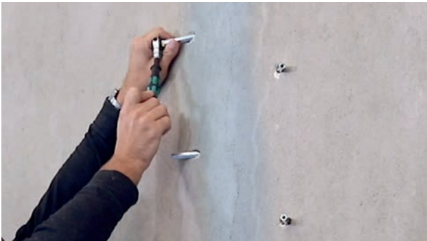
Abb. 3: Einbau der Packer
