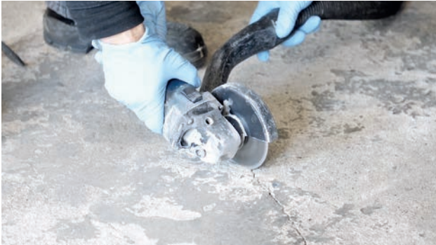
Abb. 1: Riss keilförmig öffnen
