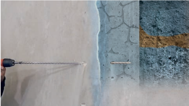
Abb. 1: Erstellen der Bohrlöcher
