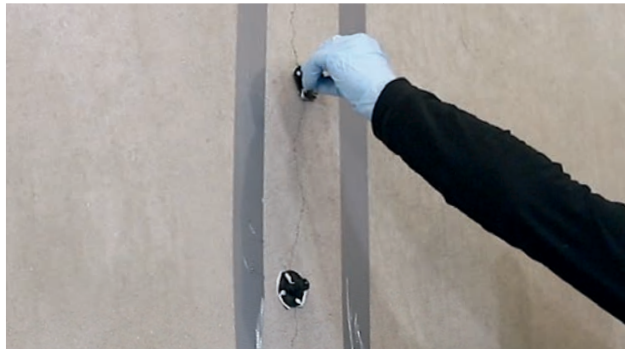
Abb. 3: Montage der Klebepacker über dem Riss
