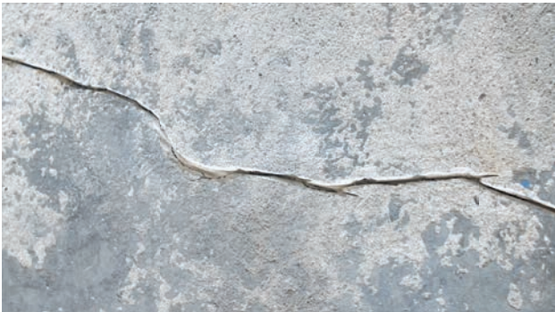
Abb. 3: Präparierter Riss vor dem Verguss
