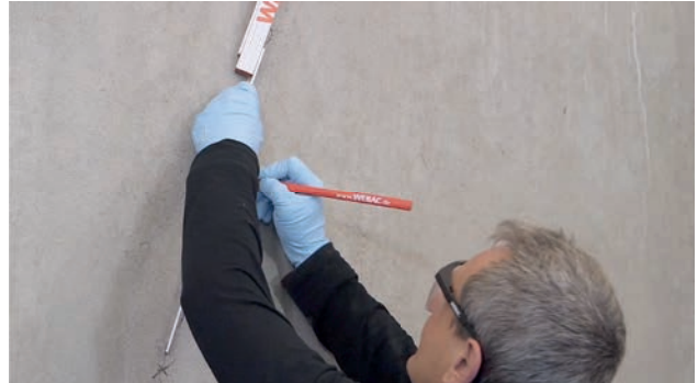
Abb. 2: Festlegen der Klebepackerabstände über dem Riss
