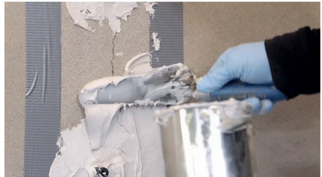
Abb. 4: Verdämmung und Einkleben der Klebepacker
