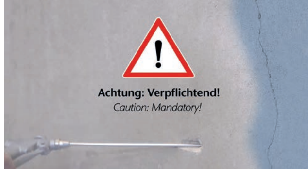
Abb. 2: Säubern der Bohrlöcher
