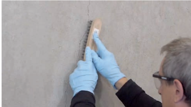
Abb. 1: Säubern der Bauteiloberfläche
