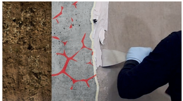
Fig. 6: Eliminación del sellado y los packer
