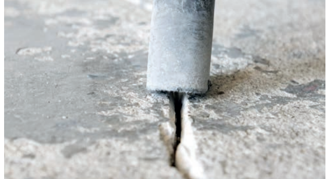
Fig. 2: Eliminar completamente el polvo
