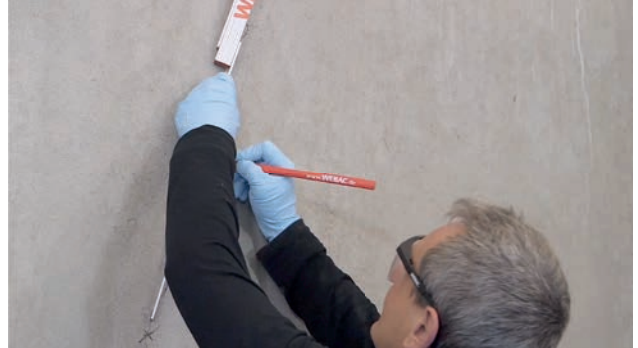
Fig. 2: Establecer las distancias del packer adhesivo sobre la grieta
