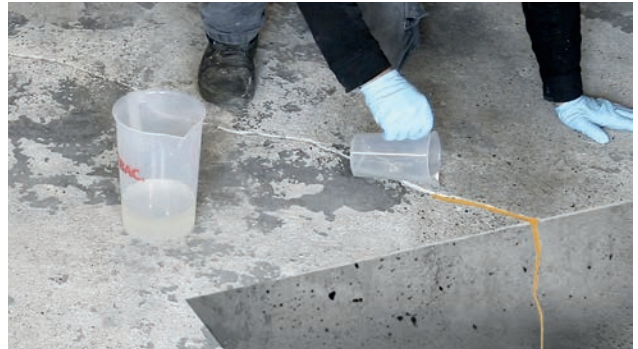
Fig. 4: Encapsulado de grieta con resina EP
