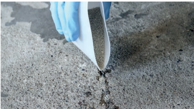
Fig. 5: Relleno de grieta tras encapsulado con arena de cuarzo
