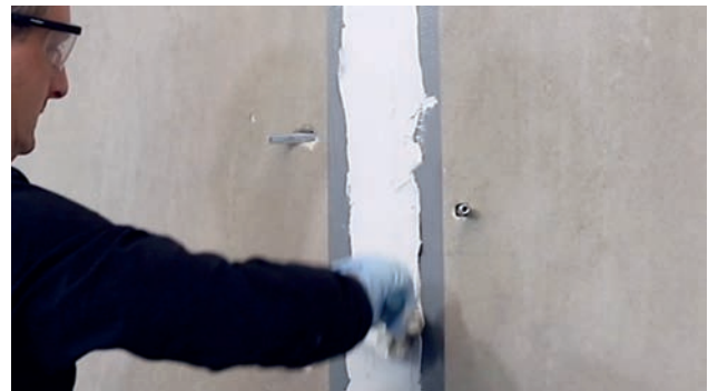
Fig. 4: Sellado de fisuras
