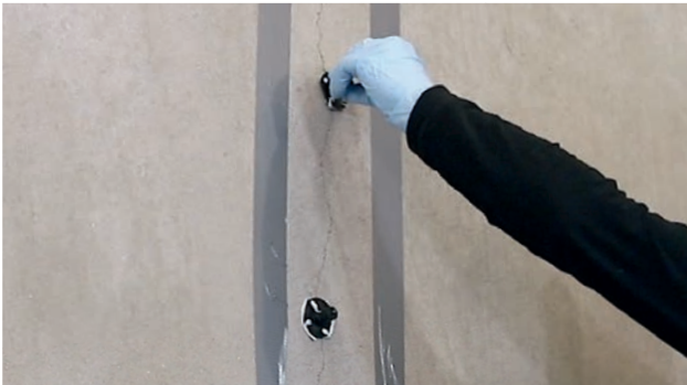
Fig. 3: Montaje de los packer adhesivo sobre la grieta
