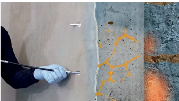
Fig. 5: Inyección de abajo a arriba
