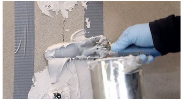
Fig. 4: Sellado y pegado de packer adhesivo
