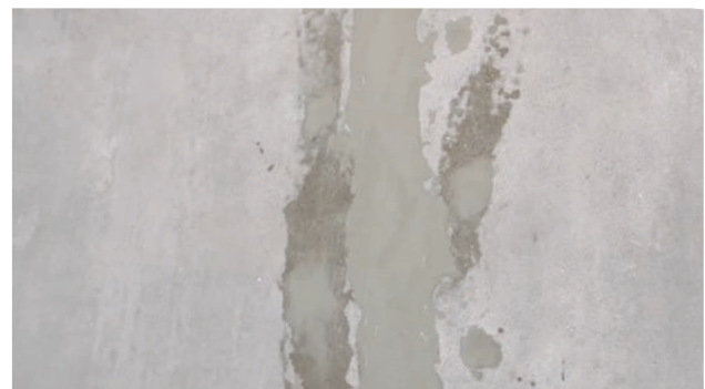
Fig. 6: Desmontaje de packer, eliminación de sellado y post-tratamiento de la grieta
