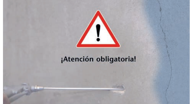
Fig. 2: Limpiar perforaciones
