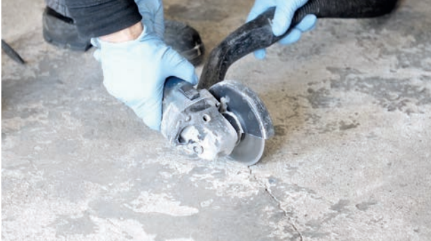
Fig. 1: Abrir grieta cuneiforme
