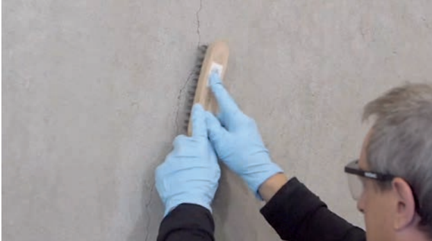
Fig. 1: Limpiar la superficie del componente
