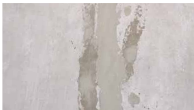
Joonis 6. Pakkerite eemaldamine, pragude katmine ja järeltöötlus
