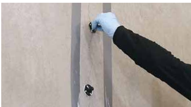
Joonis 3. Pinnapealsete pakkerite paigutamine
