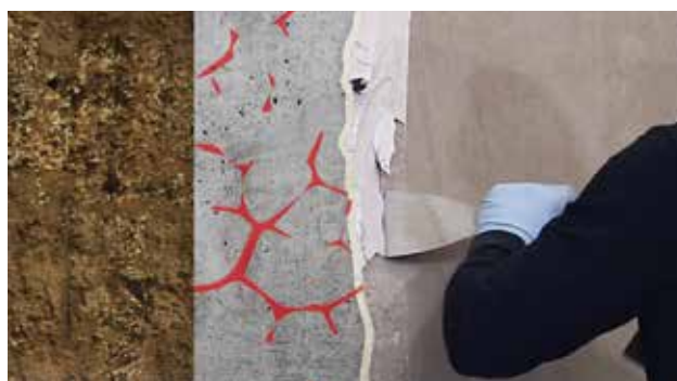
Joonis 6. Praotammistussegu ja pakkerite eemaldamine
