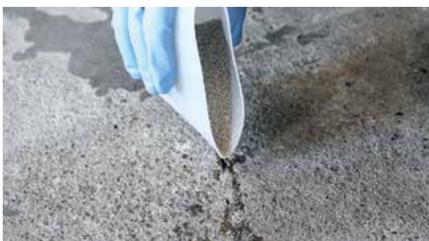
Joonis 5. Praole kvartslüüva puistamine pärast täitvat valamist
