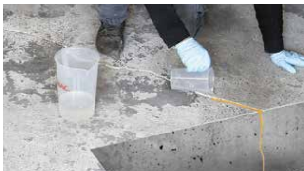
Joonis 4. Prao täis valamine epoksüvaiguga
