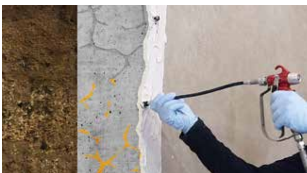
Joonis 5. Injektsioontäitmine alt ülespoole
