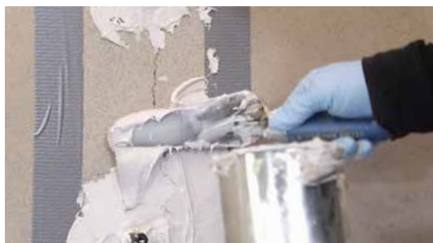
Joonis 4. Pinnapealsete pakkerite praotammistus ja liimimine
