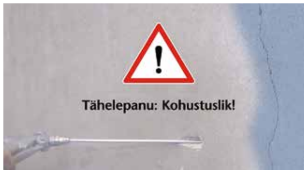
Joonis 2. Puurimistolmu eemaldamine
