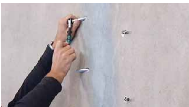
Joonis 3. Puurpakkerite paigaldamine
