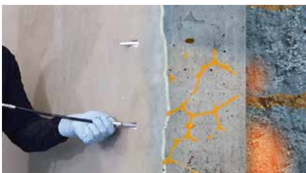
Joonis 5. Injektsioontäitmine alt ülespoole
