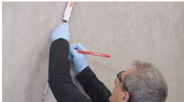
Joonis 2. Pinnapealsete pakkerite vahekauguse määramine prao kohal
