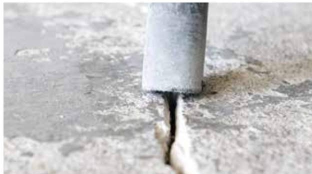
Joonis 2. Eemaldage tolm täielikult
