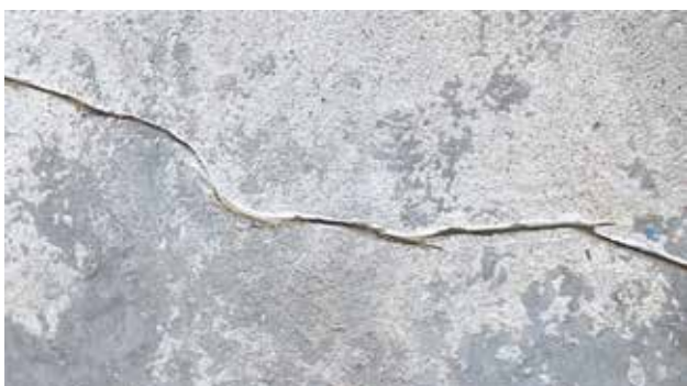
Joonis 3. Ettevalmistatud pragu enne valamist
