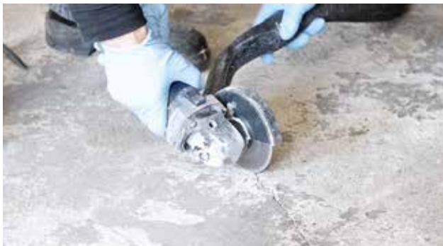
Joonis 1. Laiendage pragu vao kujulise lõikamisega
