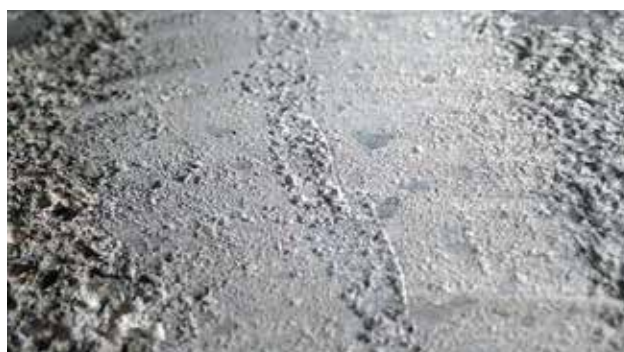
Joonis 6. Pragu pärast täitmist ja lihvimist
