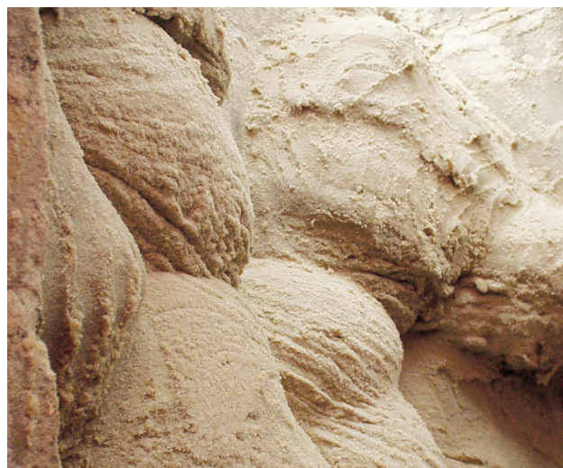
Geeli kardininjektsioon liivas, vundamendi välispinnal
