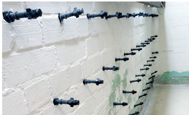
Joonis 2. Pakkerite paigutamise näide
