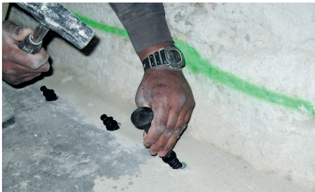
Joonis 1. Puuravade asukoha märkimine, avade puurimine ja pakkerite paigaldamine
