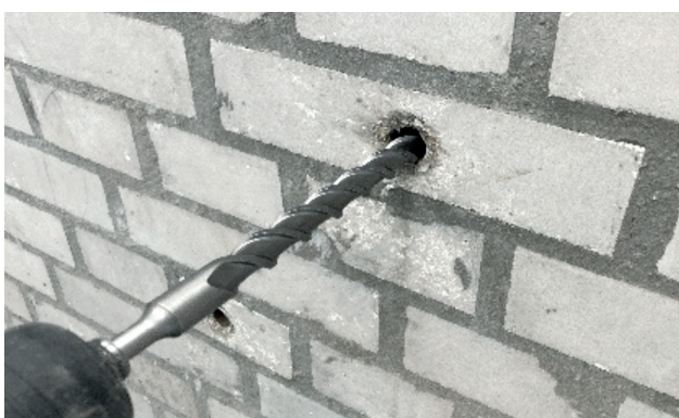
Joonis 5. Pakkerite eemaldamine: väljapuurimine (vähemalt 10 cm) ja hilisem puuravade sulgemine
