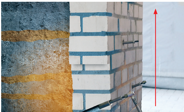
Joonis 3. Injektsioontäitmine suunaga alt ülespoole
