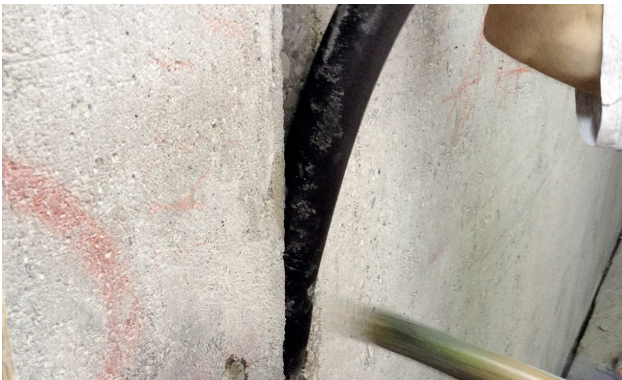
Joonis 3. Haamriga sisselöödava profiili paigaldamine
