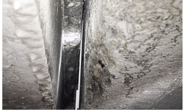
Joonis 2. Vuugi tühjendamine, vuugiservade puhastamine, vajadusel vuukide lahtilõikamine
