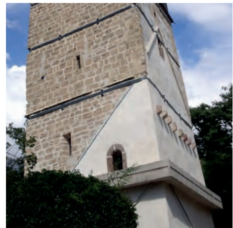
Uus kipskrohv kaldus seinapinnal
