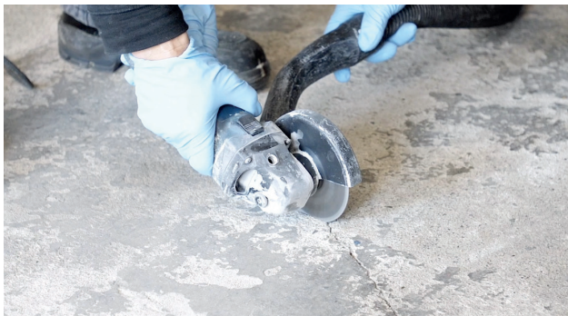
Kuva 1: Laajenna halkeama leikkaamalla
