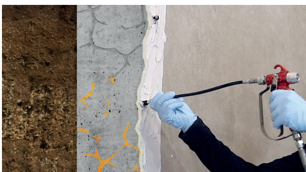
Kuva 5: Injektio alhaalta ylös
