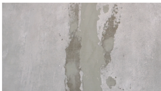
Kuva 6: Tulppien poisto, paikkauksen poisto ja halkeaman jälkikäsitely
