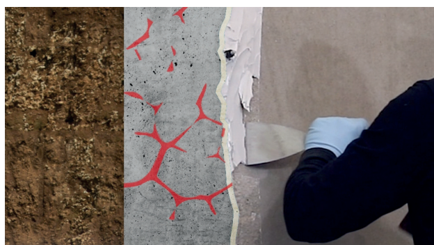
Kuva 6: Paikkauksen ja tulppien poistaminen
