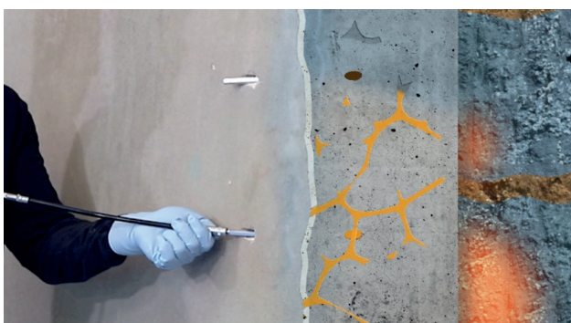
Kuva 5: Injektio alhaalta ylös
