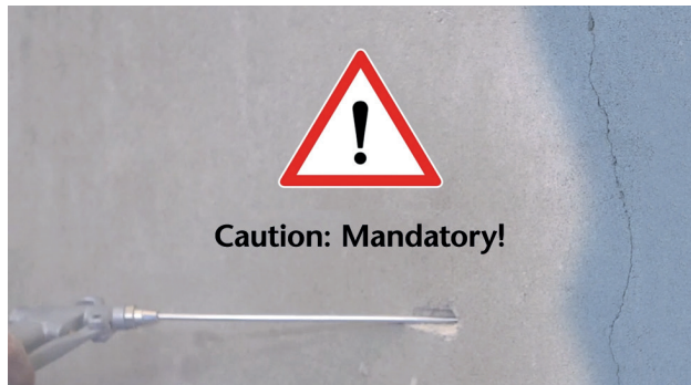
Kuva 2: Poraustomun poisto
