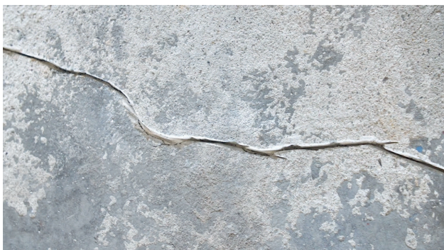
Kuva 3: Valmisteltu halkeama ennen imeyttämisen
