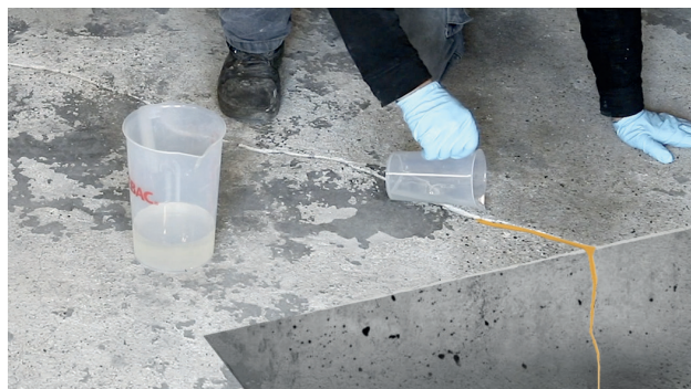
Kuva 4: Halkeaman imeyttäminen epoksihartsilla
