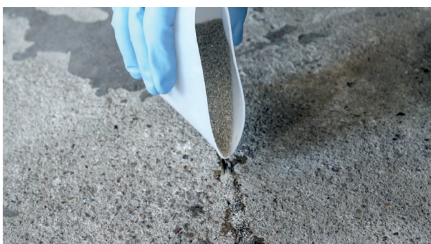
Kuva 5: Halkeaman täyttö imeyttäminen jälkeen kvartsihiekillä
