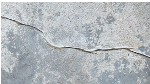
Fig. 3: Fissure préparée avant le scellement
