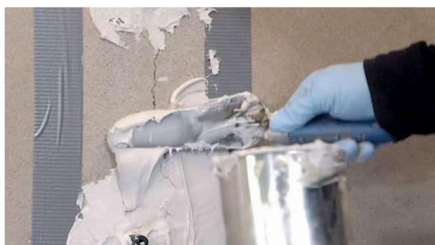
Fig. 4: Isolation et collage des injecteurs à coller
