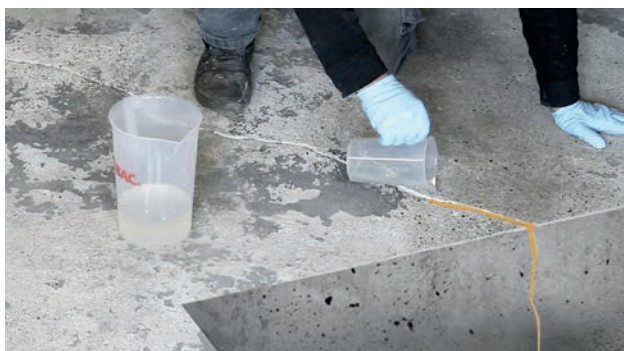
Fig. 4: Scellement de la fissure avec de la résine EP
