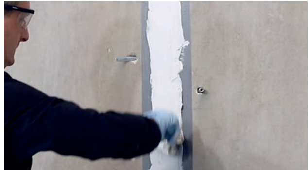
Fig. 4: Isolation de la fissure
