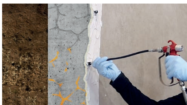
Fig. 5: Injection de bas en haut
