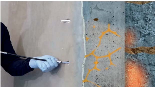
Fig. 5: Injection de bas en haut
