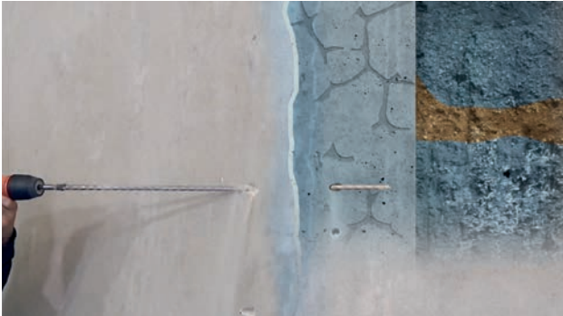
Fig. 1: Réalisation des trous de forage
