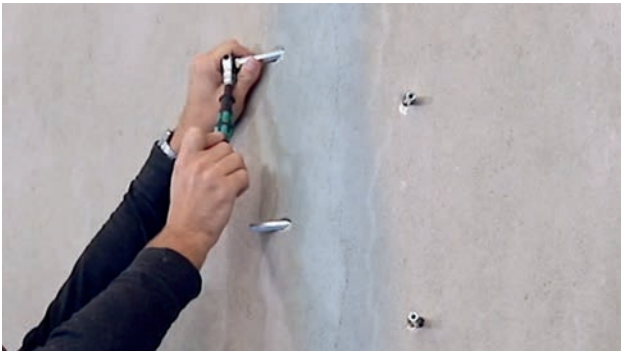
Fig. 3: Installation des injecteurs
