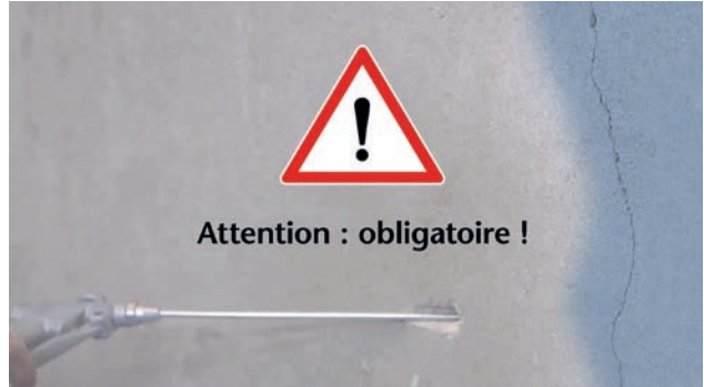
Fig. 2: Nettoyage des trous de forage
