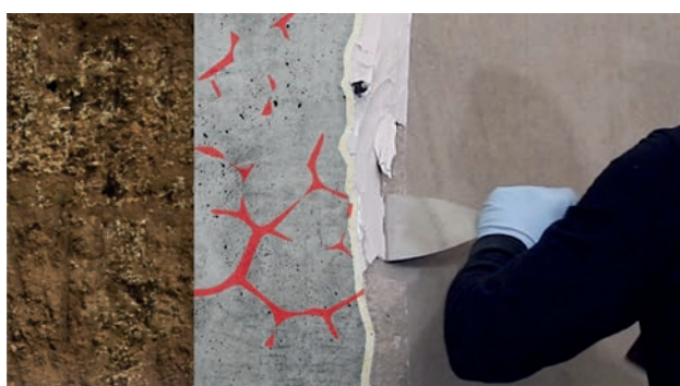
Fig. 6: Retrait de l'isolation et des injecteurs
