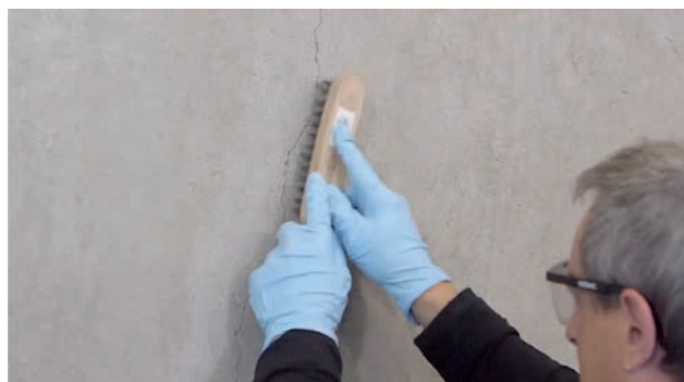
Fig. 1: Nettoyage de la surface de l'élément de construction
