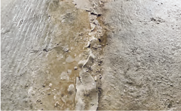
Fig. 1 : état actuel du joint avant l'étanchéité
