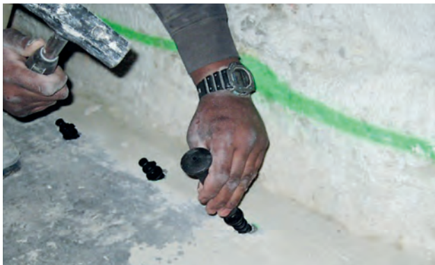
Fig. 1 : tracer la grille des trous de forage, réaliser les forages et placer les packer
