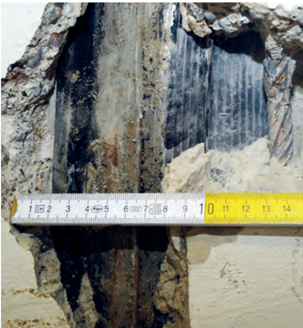
Mesure d'un joint de dilatation fragile
