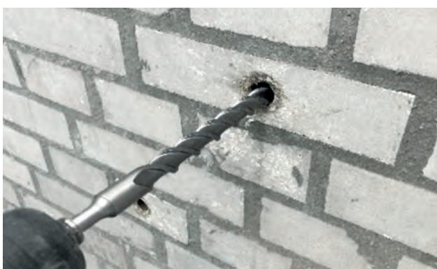
Fig. 5 : démontage des packer – perçage (au moins 10 cm) et obturation des trous de perçage
