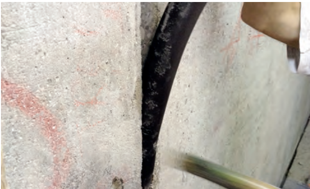
Fig. 3 : mise en place du profilé à enfoncer
