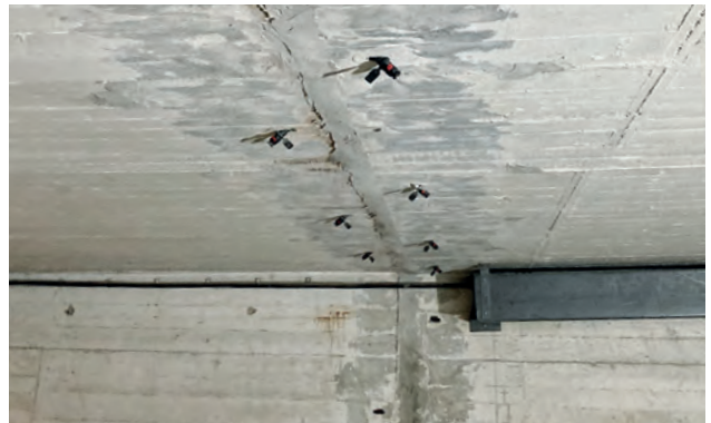
Fig. 4 : isolation des zones de joint, réalisation des trous de forage et mise en place des packer
