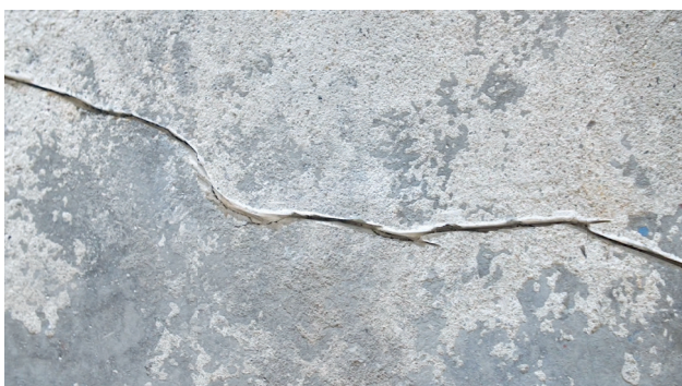
Fig. 3: Crepa preparata prima della sigillatura
