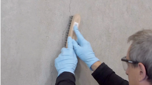
Fig. 1: Pulizia della superficie dell'elemento strutturale
