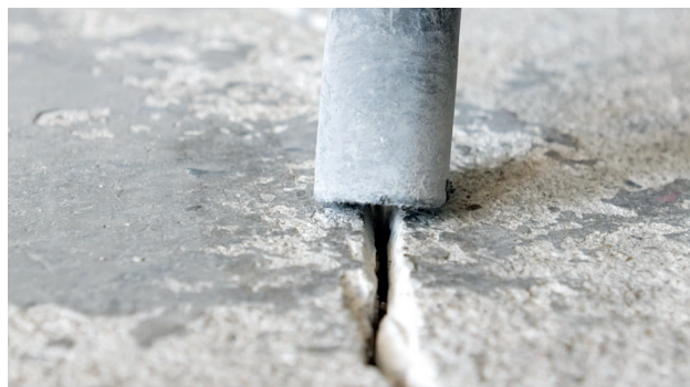
Fig. 2: Rimuovere completamente la polvere
