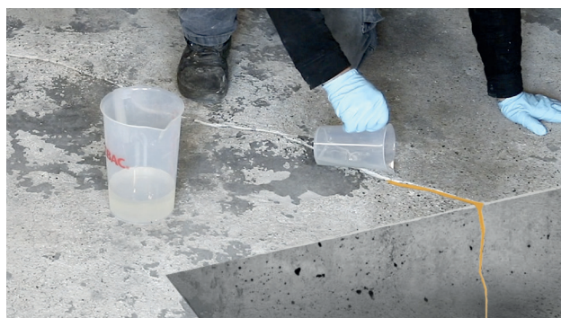
Fig. 4: Sigillatura di crepe con resina EP
