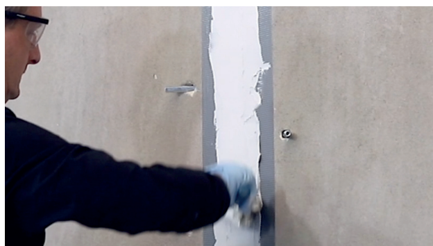
Fig. 4: Sigillatura delle crepe
