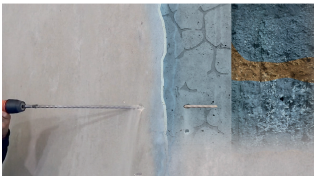
Fig. 1: Esecuzione dei fori
