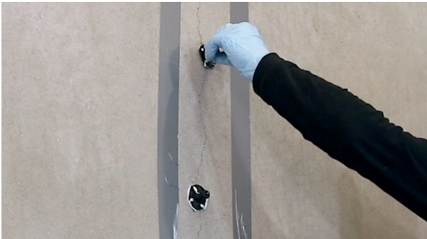
Fig. 3: Applicazione dei packer adesivi sulla crepa
