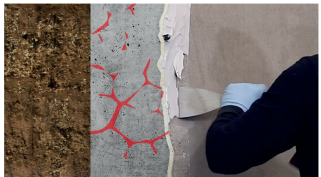
Fig. 6: Rimozione della sigillatura e dei packer
