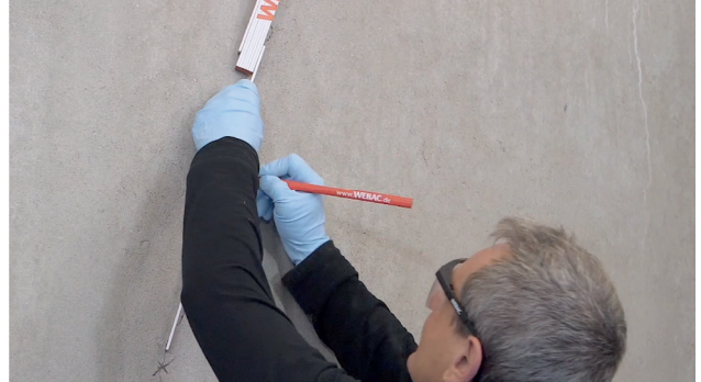
Fig. 2: Stabilire le distanze dei packer adesivi sopra la crepa
