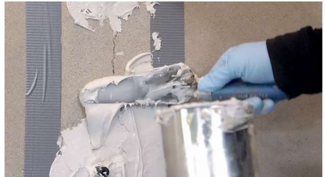
Fig. 4: Sigillatura e incollaggio dei packer adesivi
