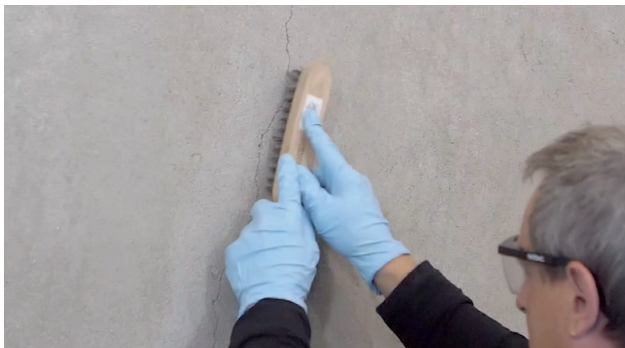
Fig. 1: Limpeza da superfície
