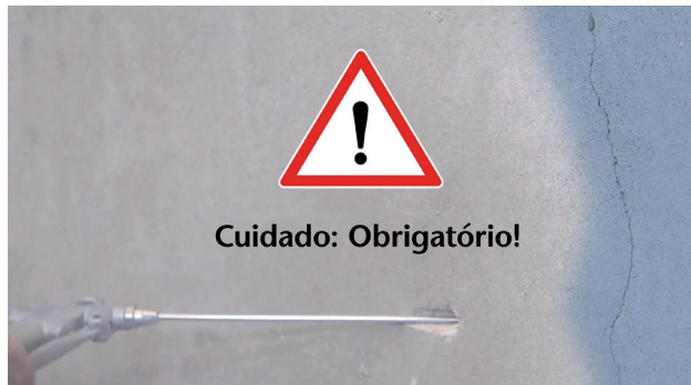
Fig. 2: Removendo a poeira dos furos
