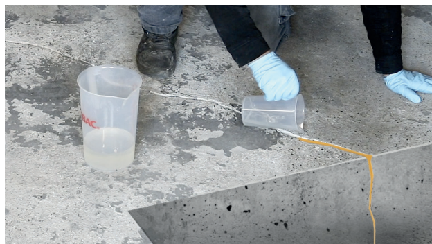
Fig. 4: Fissura impregnada com resina epóxi
