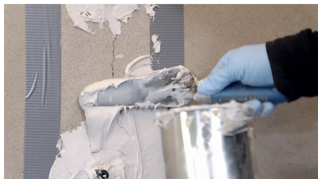
Fig. 4: Calafetação e colagem dos bicos de adesão
