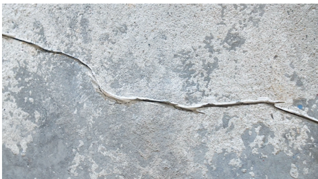
Fig. 3: Fissura preparada antes da impregnação
