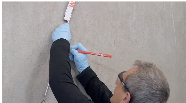
Fig. 2: Determinando o espaçamento dos bicos de adesão de superfície acima da fissura
