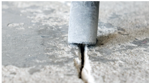
Fig. 2: Remova a poeira completamente
