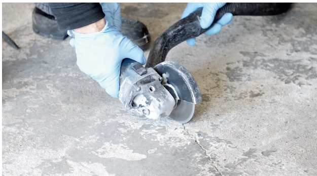
Fig. 1: Amplie a trinca recortando
