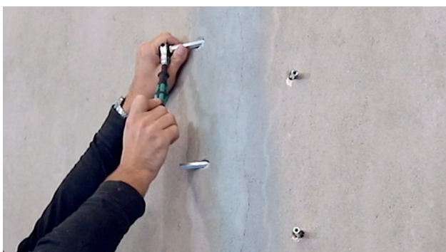
Fig. 3: Instalando os bicos
