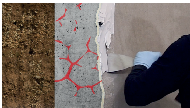
Fig. 6: Remoção da calafetação e bicos
