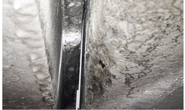
Fig. 2: Limpar a junta, limpar as bordas da junta, cortar juntas abertas, se necessário
