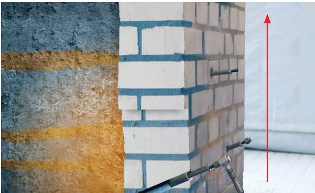
Fig. 3: Injeção de baixo para cima
