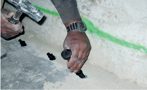
Fig. 1: Marcação da posição dos furos, faça furos e coloque os bicos
