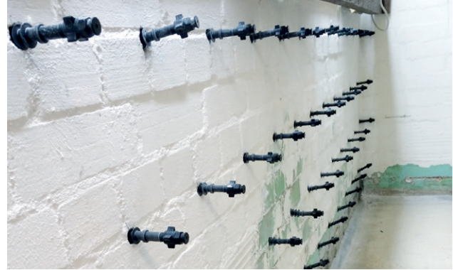
Fig. 2: Exemplo de disposição dos bicos
