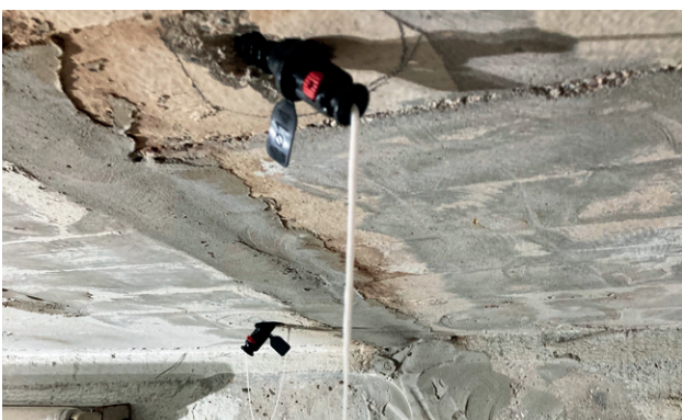
Fig. 5: Injetando o material
