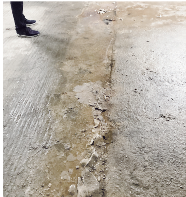
Estado de construção antes da reforma
