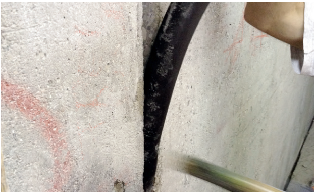
Fig. 3: Instalando o perfil de impacto
