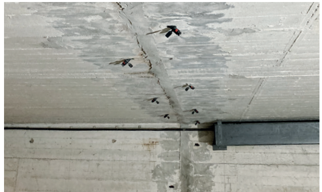
Fig. 4: Isolamento das áreas articuladas, criando os furos e colocando os packers
