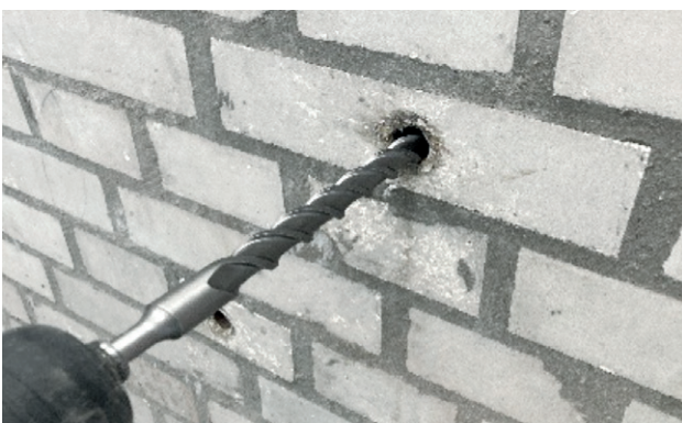
Fig. 5: Remoção dos bicos de perfuração (pelo menos 10 cm) e vedação dos furos
