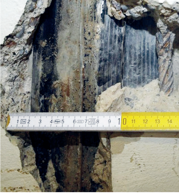
Kırılgan bir genleşme derzinin ölçümü
