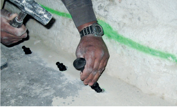
Şekil 1: Sondaj deliği şemasının, sondaj deliklerinin ve yerleştirme pakelerinin işaretlenmesi
