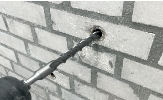
Şekil 5: Pakelerin çıkarılması - delme (en az 10 cm) ve deliklerinin kapatılması
