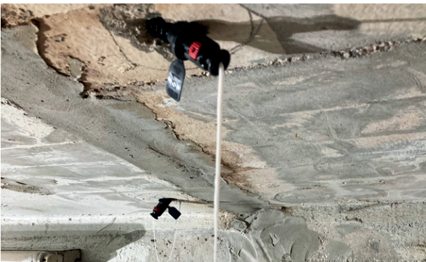
Şekil 5: Malzeme enjeksiyonu
