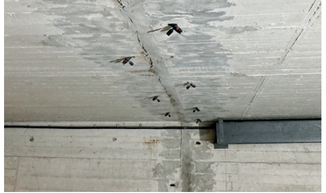
Şekil 4: Derz alanının hızlı harç ile kapatılması, deliklerin açılması ve pakerlerin yerleştirilmesi
