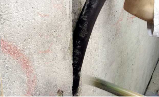
Şekil 3: Çekiç profilinin takılması
