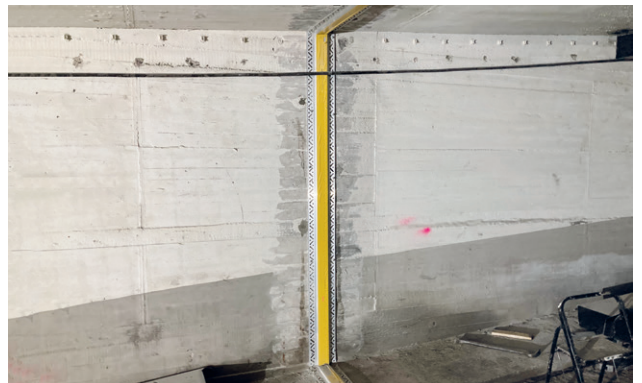
Şekil 6: Bakımı yapılmış derz
