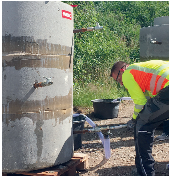
Injektion von WEBAC® HIS
